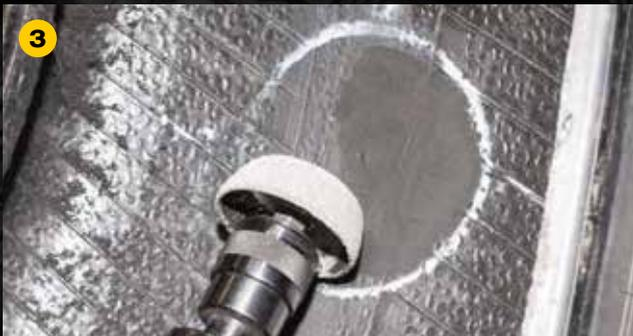
3 Mit dem Stabschleifer (Bestell-Nr. 9551 554 100) anrauen und mit der Druckluft-Saugpistole (Bestell-Nr. 9505 155 090) absaugen.
